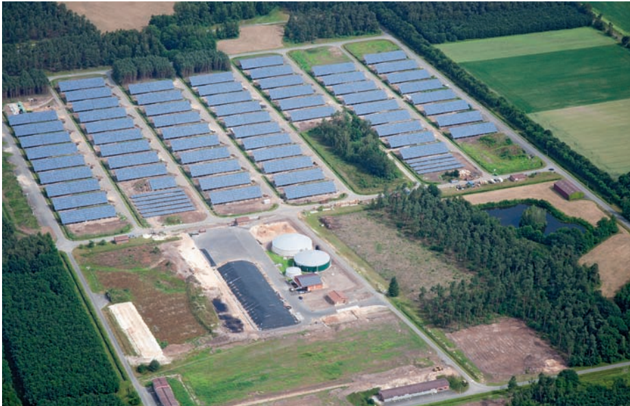
Bioenergiepark (BEP) Saerbeck
