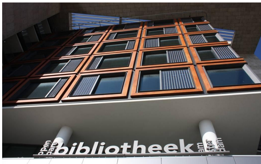
Figuur 3.4 De Openbare Bibliotheek Amsterdam, een voorbeeld van duurzaam bouwen. De nieuwe centrale bibliotheek op het Oosterdokseiland heeft de prijs voor het meest duurzame publiek toegankelijke gebouw van Amsterdam gekregen. De prijs is ingesteld door Dutch Green Building Council, Kinderen van Nu, de gemeente Amsterdam en de Provincie Noord-Holland. De prijs werd uitgereikt op het Nationaal Sustainability Congres (november 2008).
