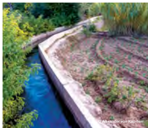
Bewässerungsarbeiten im Norden von Agadir | Projet d'irrigation au nord d'Agadir
